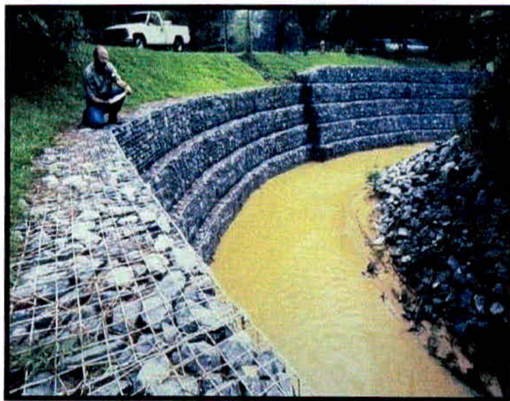
Figura 11 - Exemplo de gabião (Fonte: www.geobrasil.com ).
