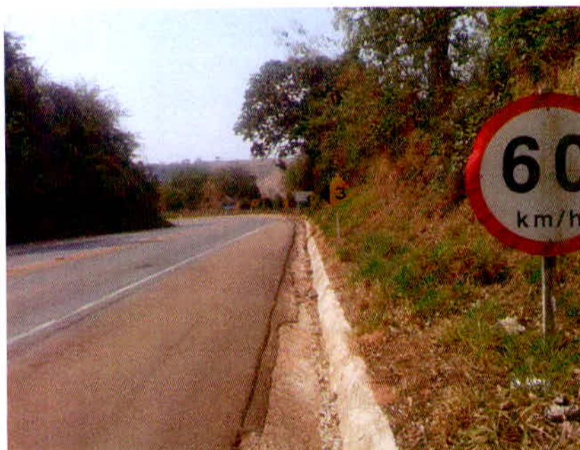
Figura 13 - Imagem do local em estudo, placa regulamentando a velocidade
