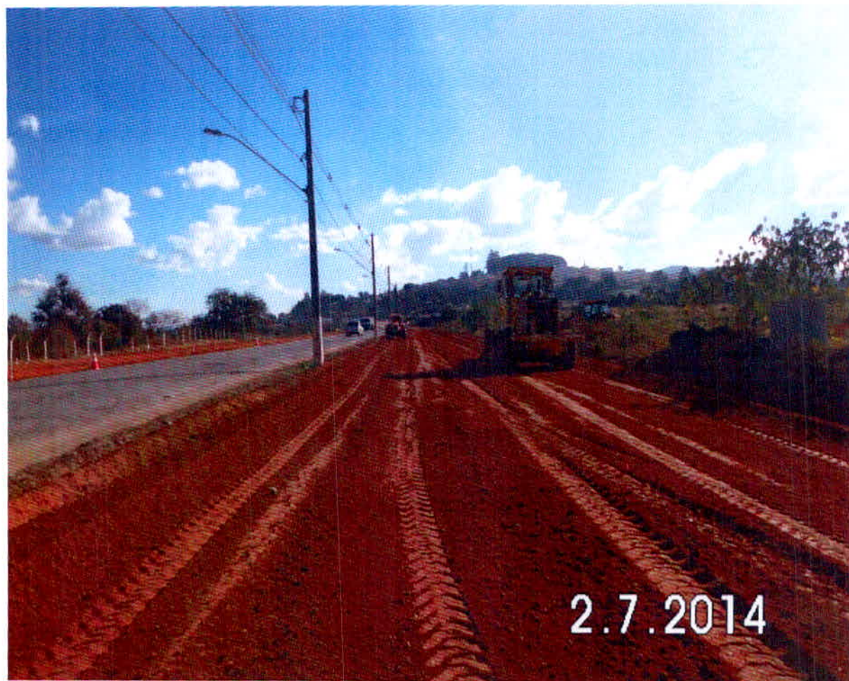
Figura 12 – Camada de sub-base com argila
