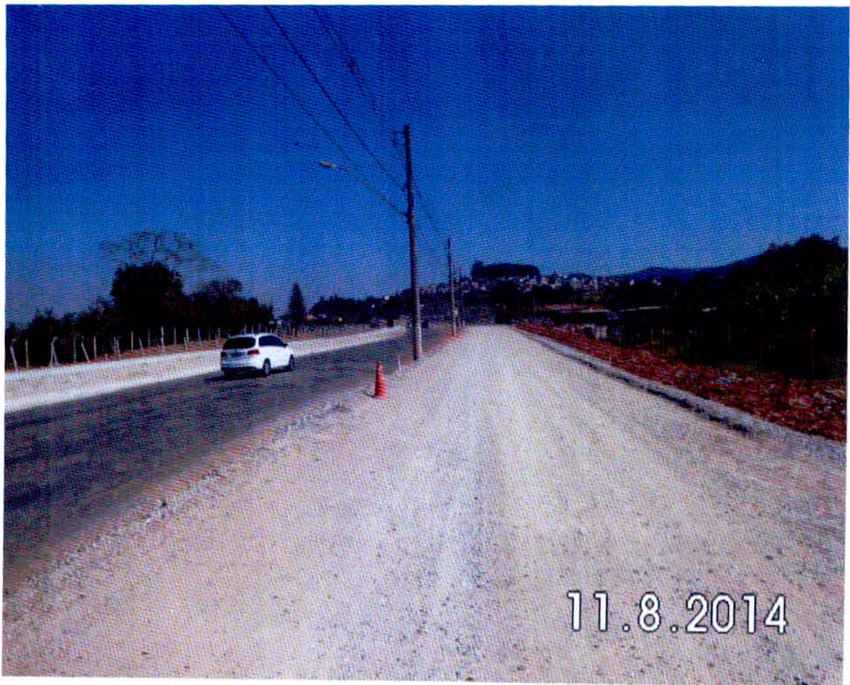
Figura 17 – Camada de sub-base de macadame
