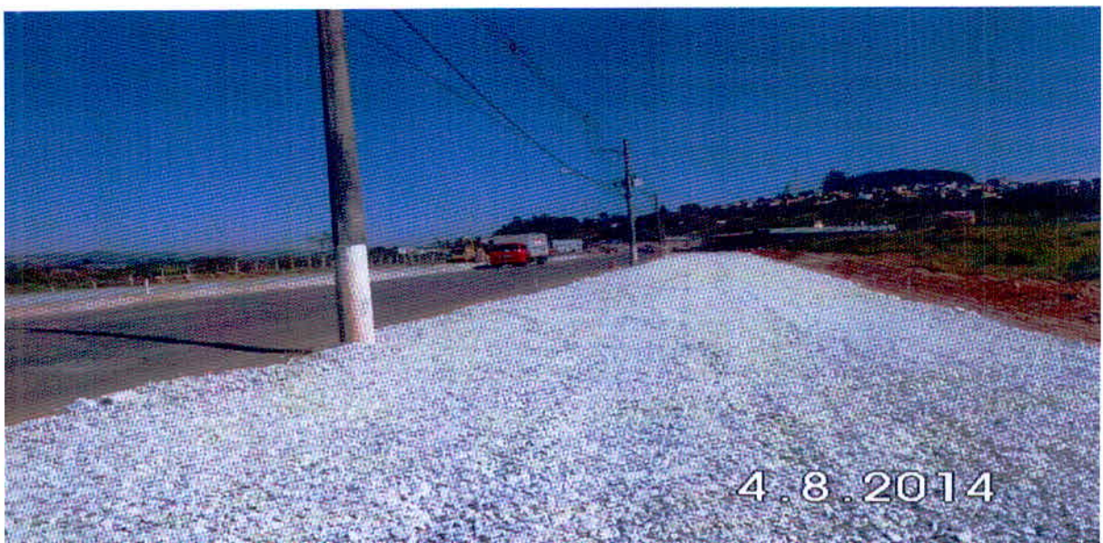
Figura 15 - Camada de sub-base com pedra de mão e brita 03
