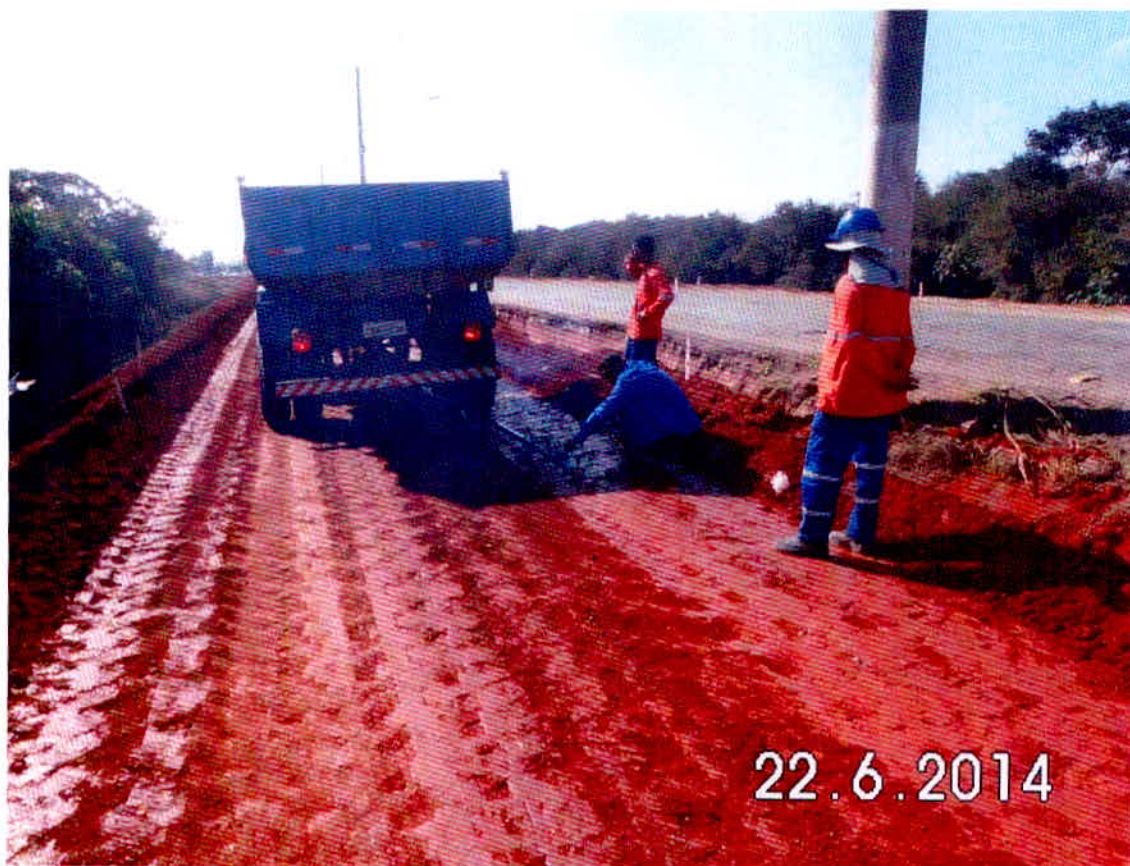
Figura 03- Medida com viga Benkelman em campo
