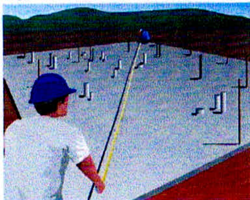
Figura 14 - Verificação das diagonais.
