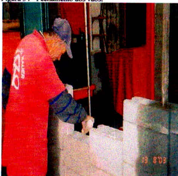
Figura 34 - Fechamento dos vãos.
