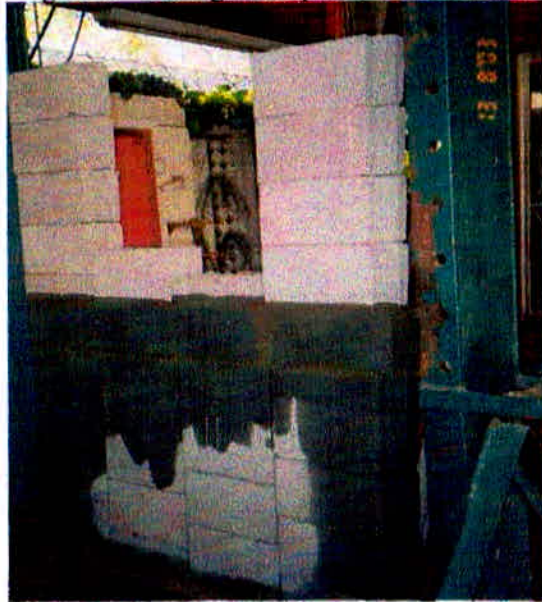
Figura 37 - Montagem dos pilares e fechamento dos vãos.
