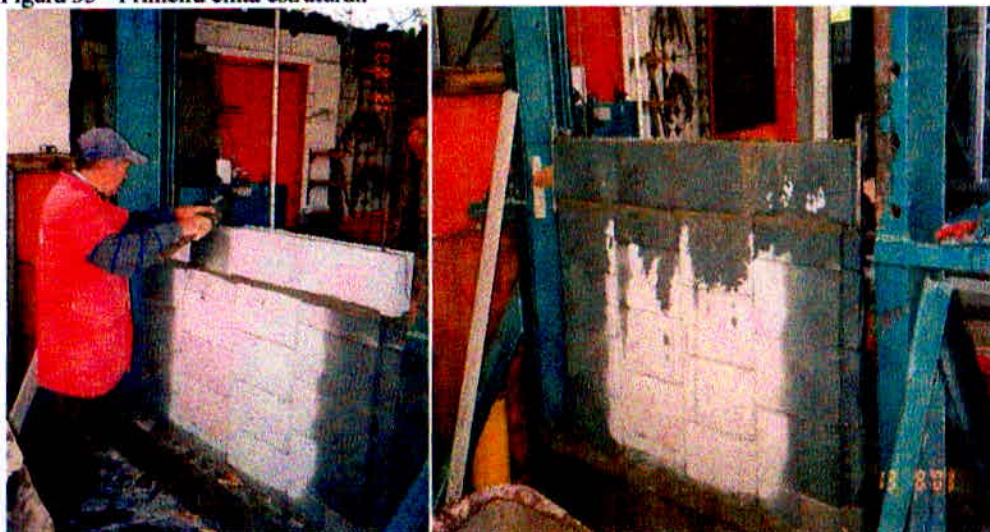
Figura 35 - Primeira cinta estrutural.
