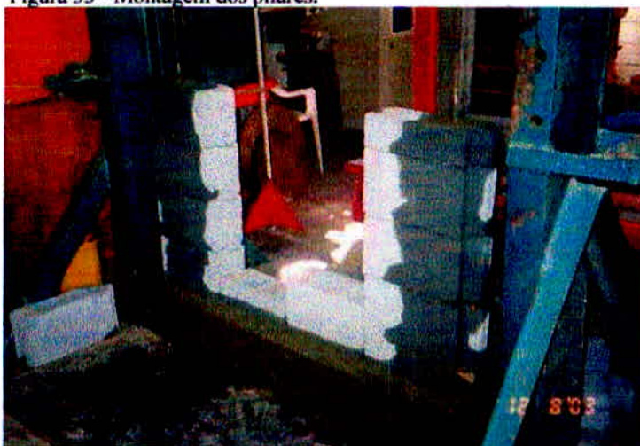
Figura 33 - Montagem dos pilares.
