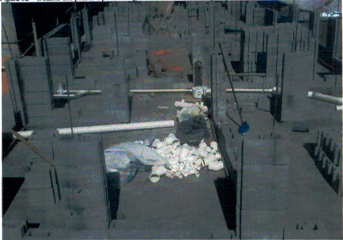
Figura 52 - Detalhe dos pilares e pontos de grauteamentos realizados pelo pedreiro.
