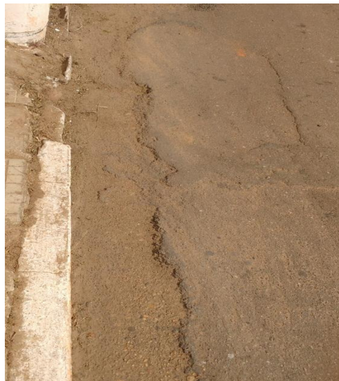
Figura 13: Sarjeta com redução nas dimensões.
