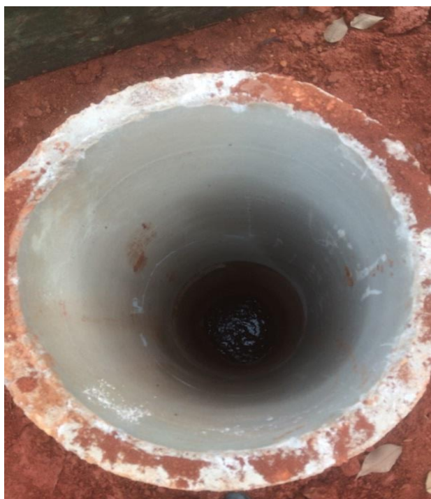
Figura 15: Poço de visita
