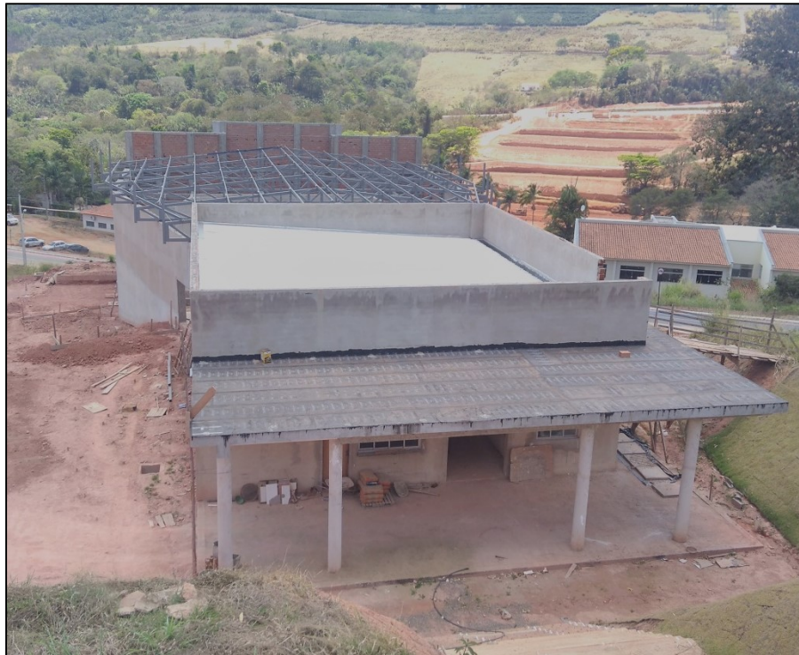
Figura 1 - Auditório do Instituto Federal do Sul de Minas, campus Machado.
