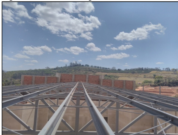
Figura 3 - Cobertura duas águas do auditório.
