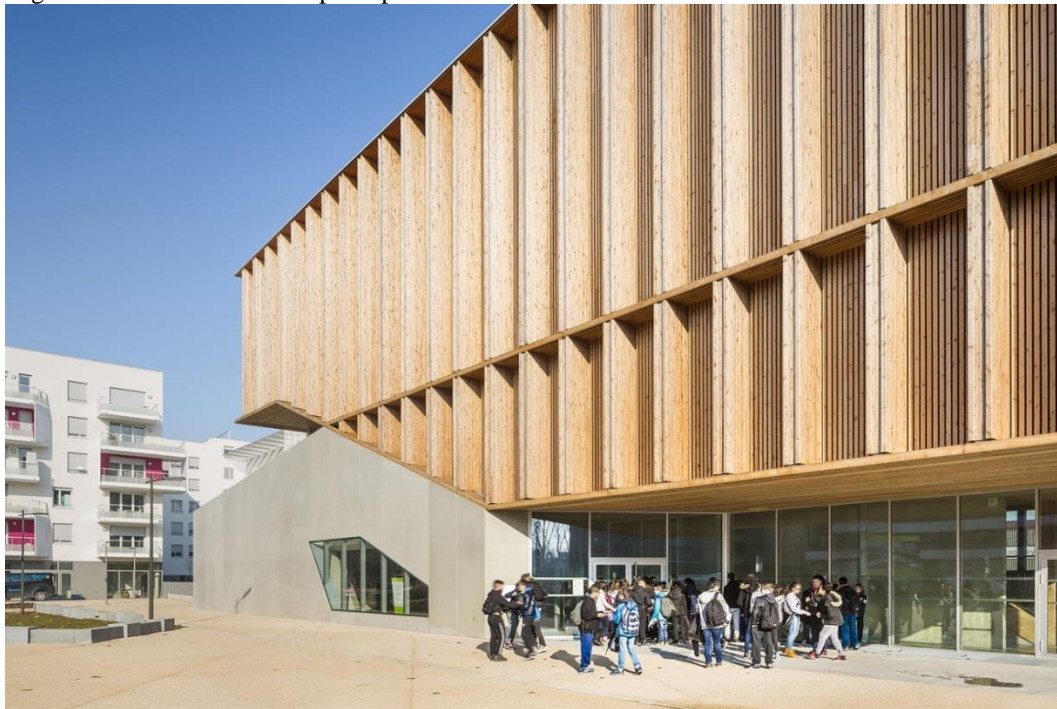
Figura 27 – Fachada entrada principal.
