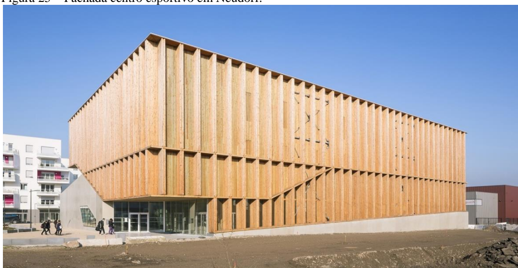
Figura 25 – Fachada centro esportivo em Neudorf.
