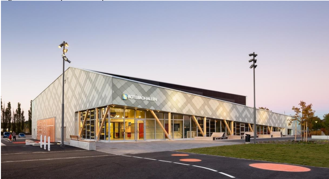
Figura 16 – Vista pavilhão desportivo em Rotebro.
