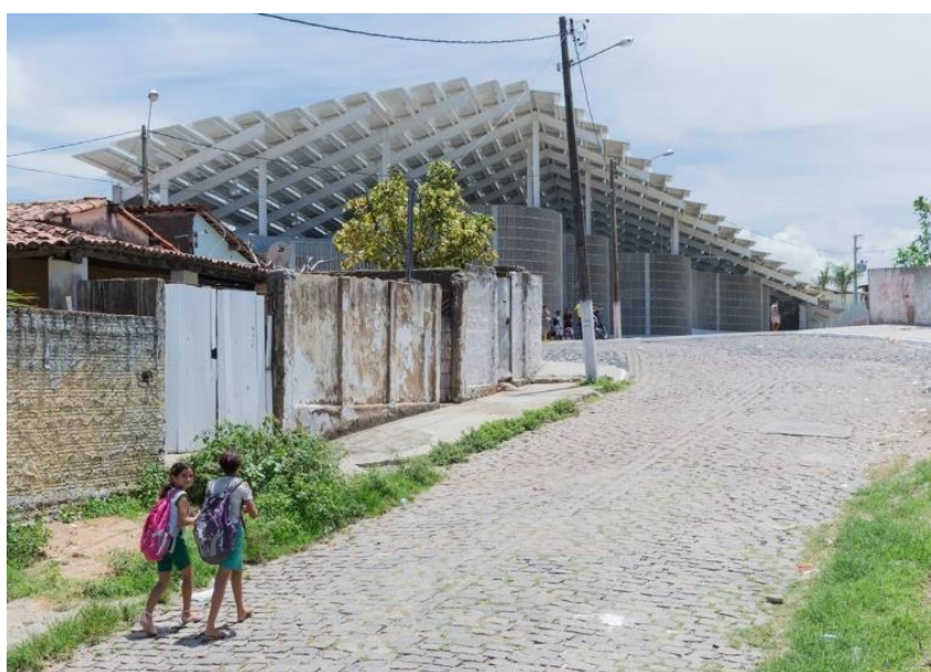
Figura 21 - Vista inferior da cobertura.
