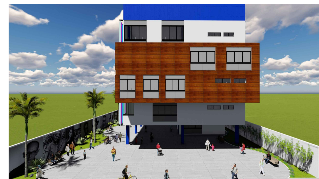
Estrutura em balanço
