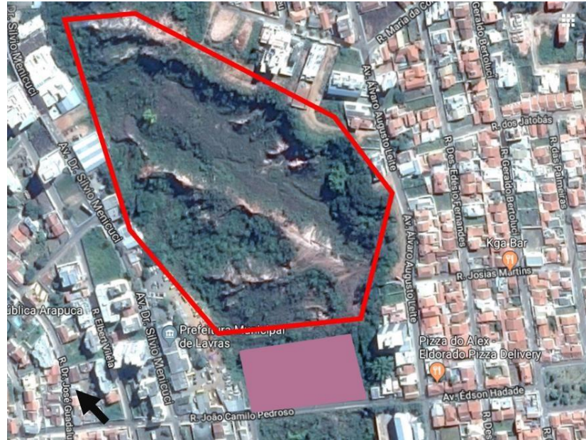
Figura 34 - Voçoroca próxima ao terreno Fonte: Google Earth e a autora
