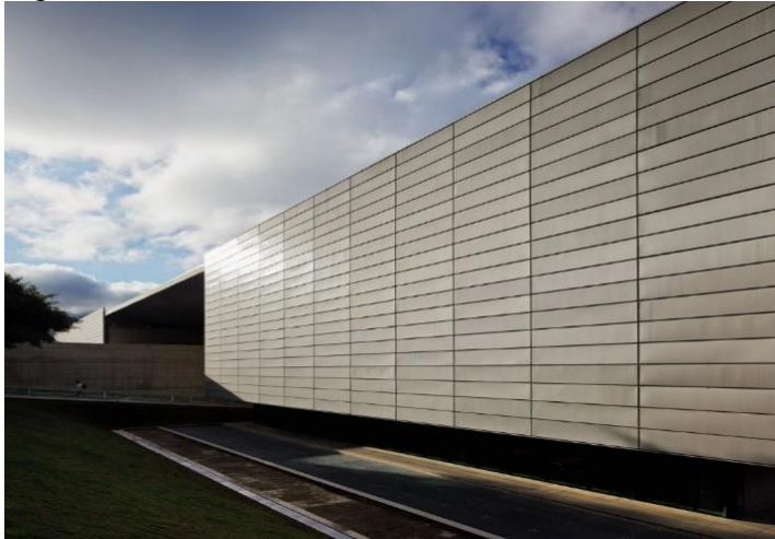
Figura 20 - Fachada leste da Biblioteca Brasileira.
