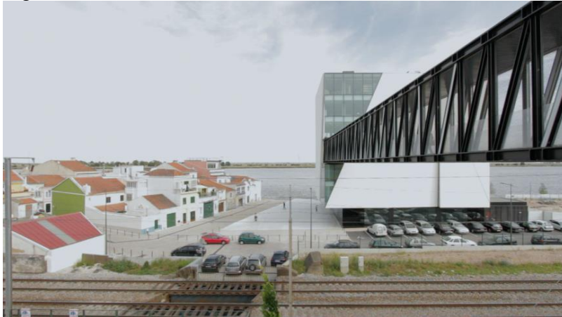
Figura 26 - Ponte em Estrutura metálica da Biblioteca Fabrica das Palavras.
