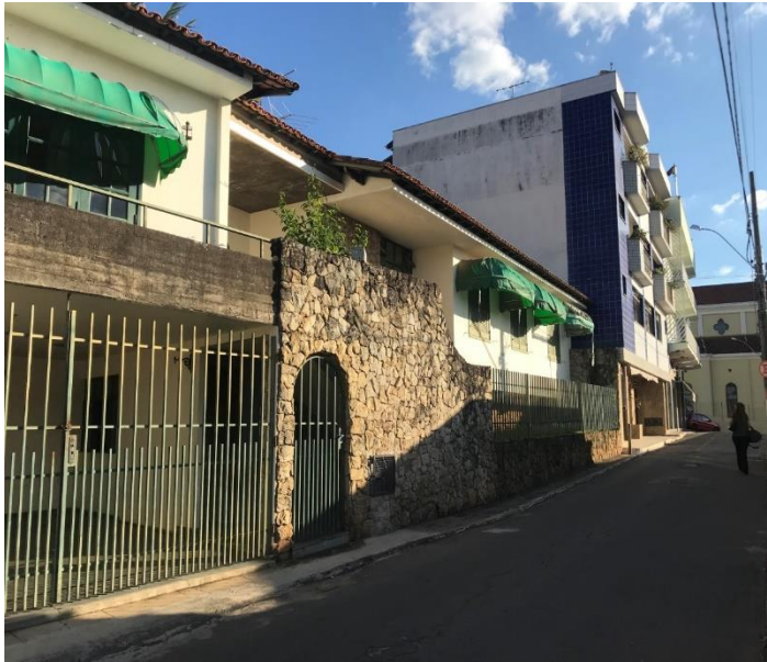
Figura 51 – Calçada da Rua da Matriz
