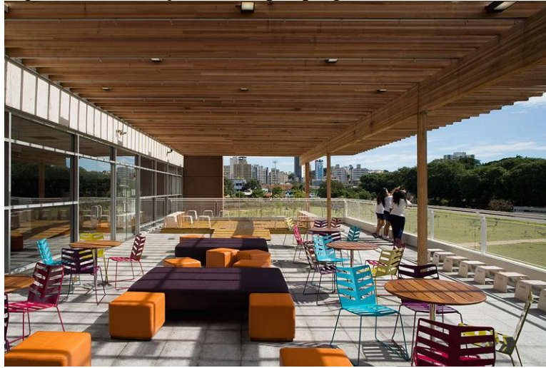
Figura 34 – Terraço coberto por pérgulas.
