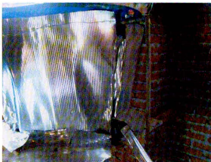
Figura 23: Isolação do ASBC
