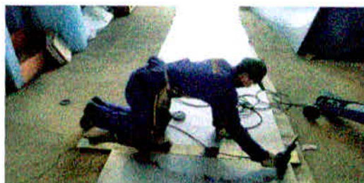
Figura 01: Corte com lixadeira
