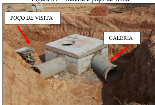
Figura 39 – Galeria e poço de visita
