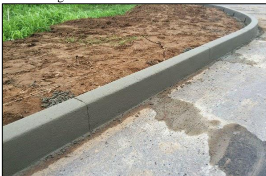
Figura 41 - Meio-fio em concreto
