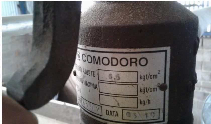
Figura 12: Segunda - Válvula de Segurança 6,5Kgf/cm 2 /Comodoro VS-100, diâmetro de 1 ½” Fonte: O Autor, 2019.
