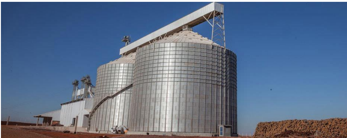
Figura 6- Silos Metálicos Planos
