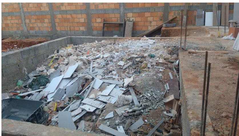
Figura 9: reforma e ampliação de imóvel utilizando resíduos da construção civil.
