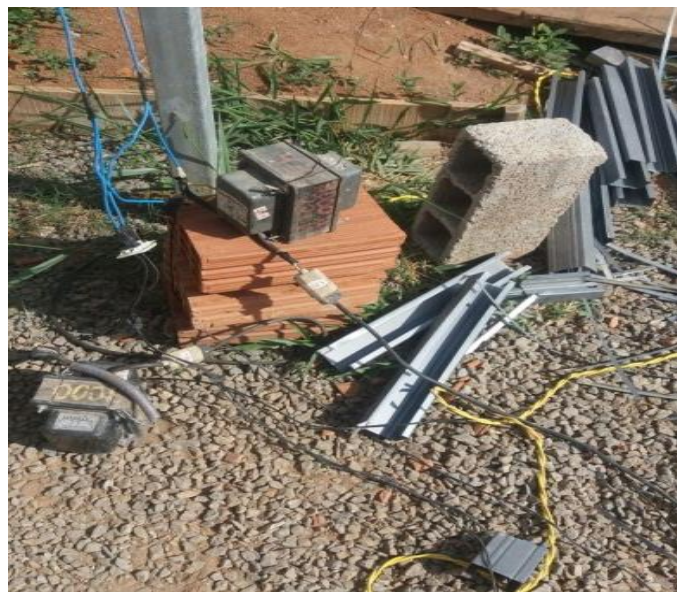
Figura 36: Instalação Exposta
