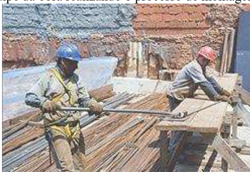
Figura 02 - Equipe da obra realizando o processo de montagem das armaduras
