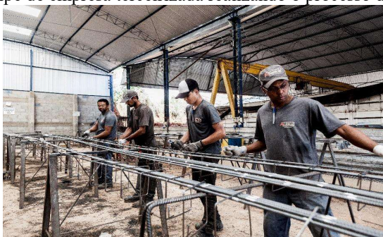
Figura 4 – Equipe de empresa terceirizada realizando o processo de armação das armaduras
