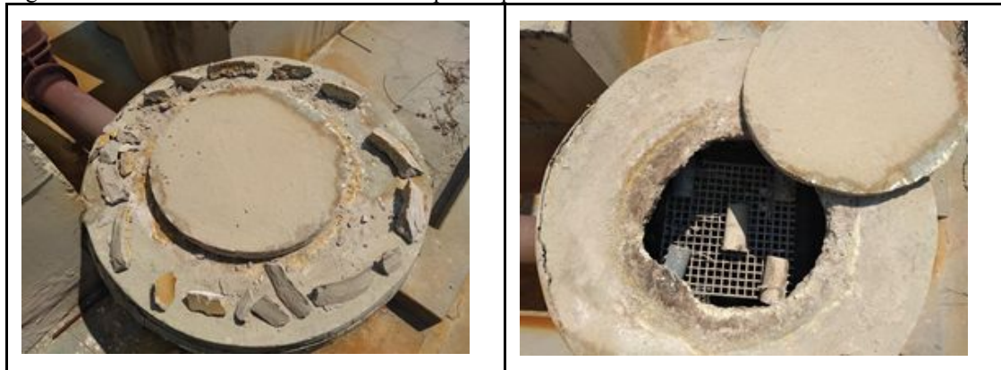
Figura 04 - abertura do PV e retirada dos corpos de prova
