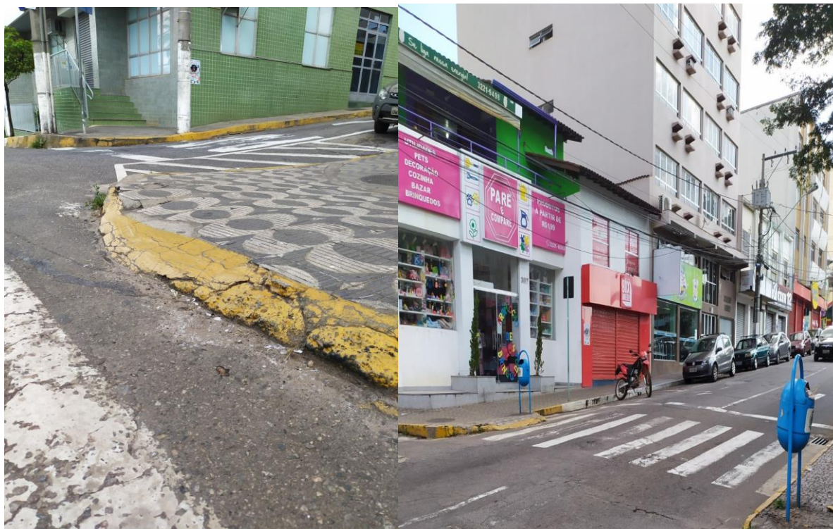
Figura 16 - Rebaixamento de calçada e faixa de pedestre.
