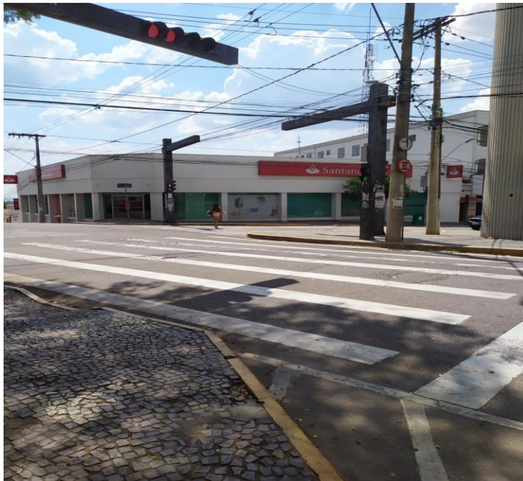
Figura 9 - Cruzamento da Rua Dona Zica com a Avenida Rio Branco
