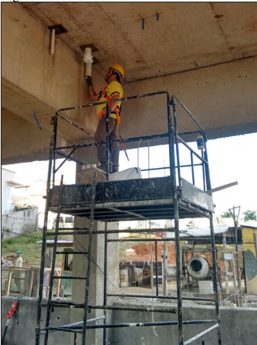
Figura 29 - Trabalho em altura
