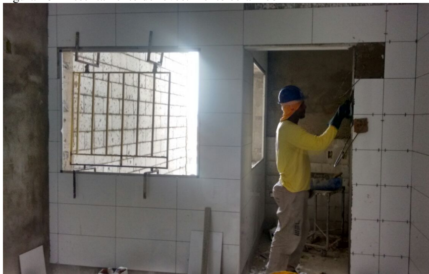
Figura 26 - Assentamento de revestimento cerâmico
