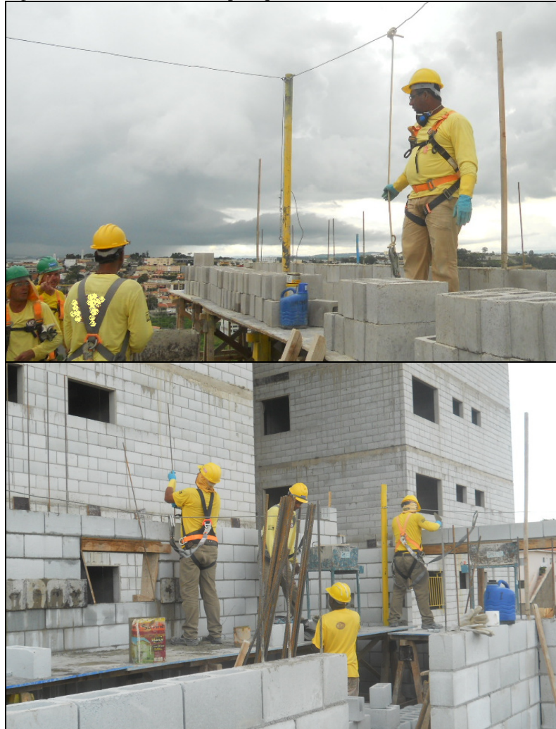
Figura 15 - Andaimes e cinto paraquedista
