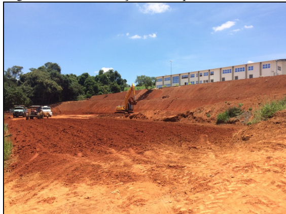
Figura 4 - Movimentação de máquinas
