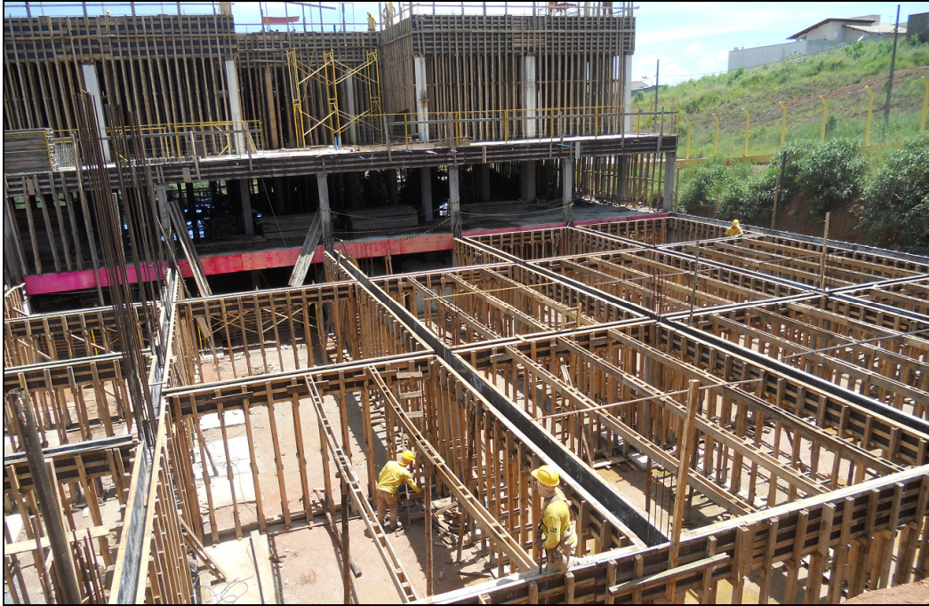
Figura 16 - Vergalhões expostos / Estruturas de concreto
