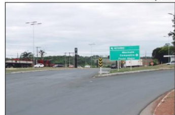
Ainda falta sinalização completa para conclusão do trevo
