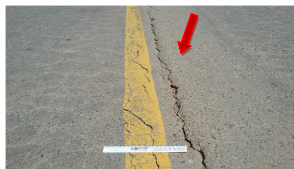
Trinca Longitudinal
