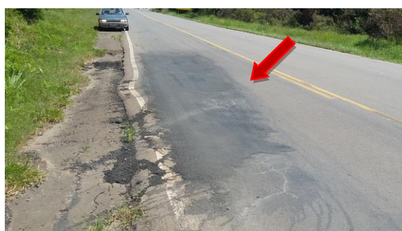
Remendo do Revestimento com deterioração.
