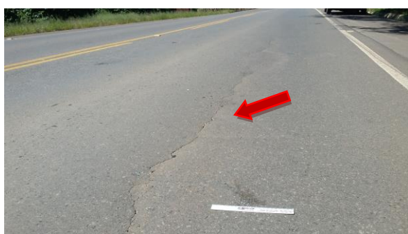
Trinca Longitudinal
