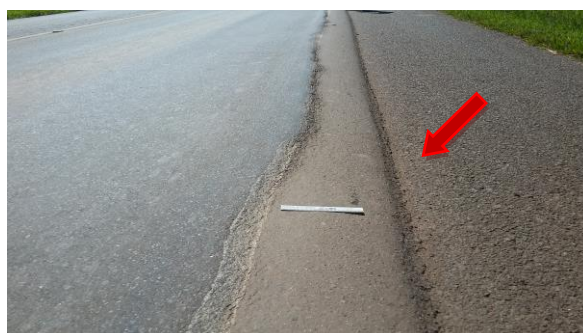
Desnível entre a Pista e o Acostamento
