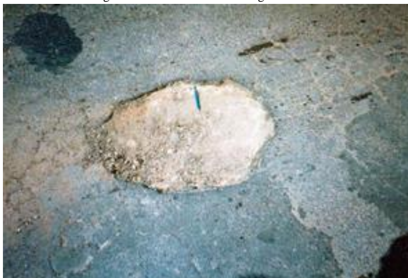
Figura 13 - Panela e Panela atingindo a base.
