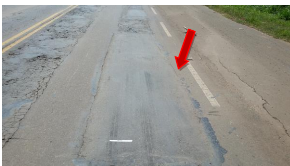
Remendo do Revestimento com deterioração
