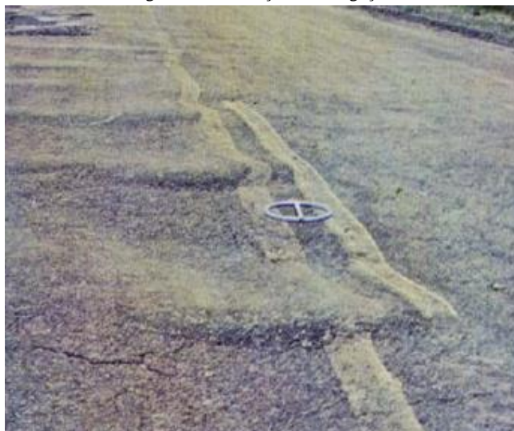
Figura 9 - Ondulação / Corrugação.
