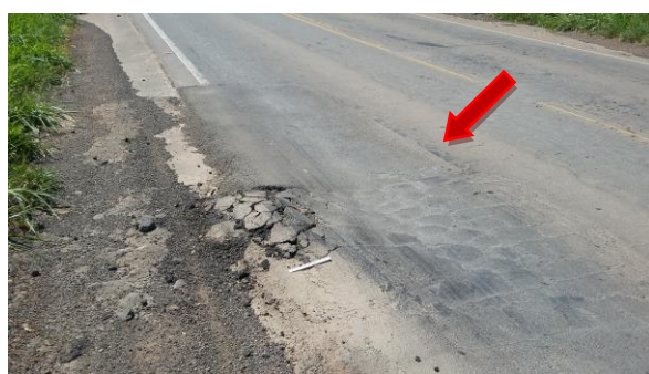
Remendo do Revestimento com deterioração
