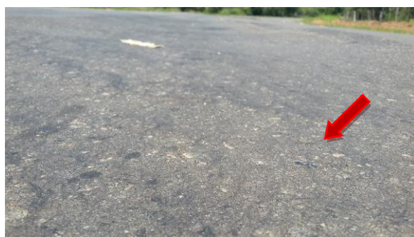
Revestimento com Polimento dos Agregados
