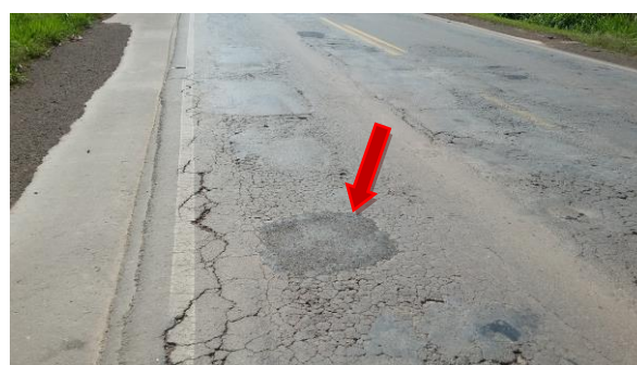
Remendo do Revestimento com deterioração
