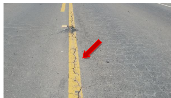
Trinca Longitudinal
