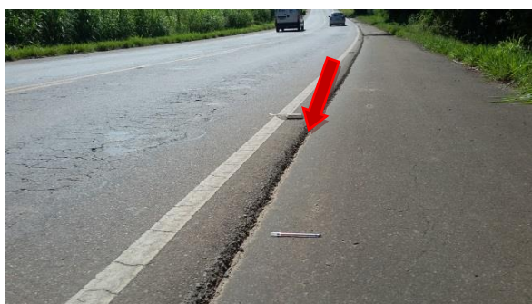
Desnível entre a Pista e o Acostamento
