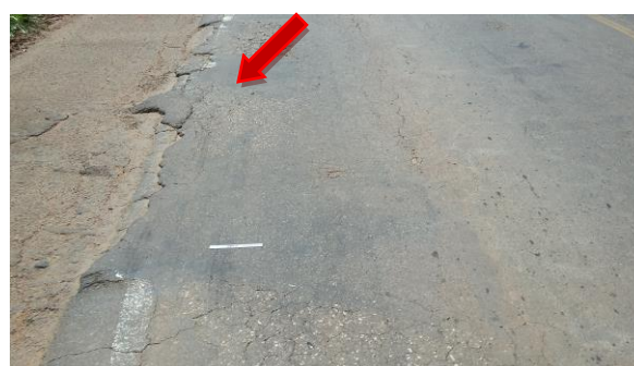
Remendo do Revestimento com deterioração
