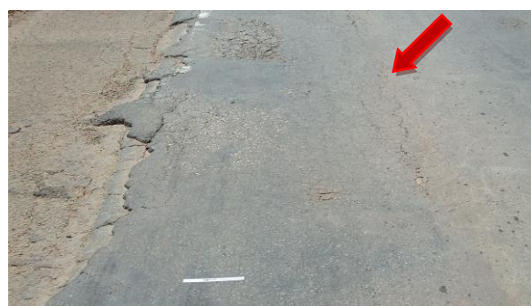
Trinca Longitudinal
