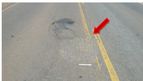
Remendo do Revestimento
