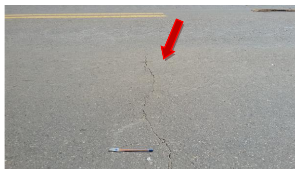
Trinca Longitudinal
