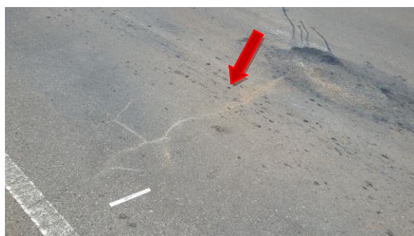
Trinca Transversal
