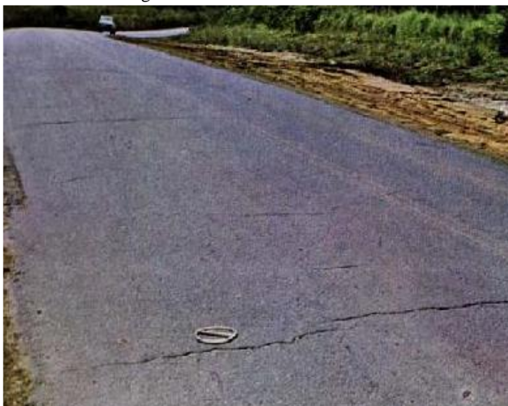
Figura 4 - Trincas transversais.
