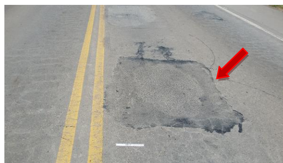
Remendo do Revestimento
