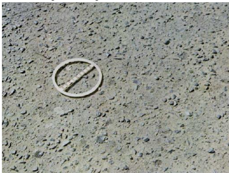
Figura 12 - Desgaste do Pavimento Flexível.
