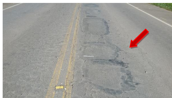
Remendo do Revestimento.
