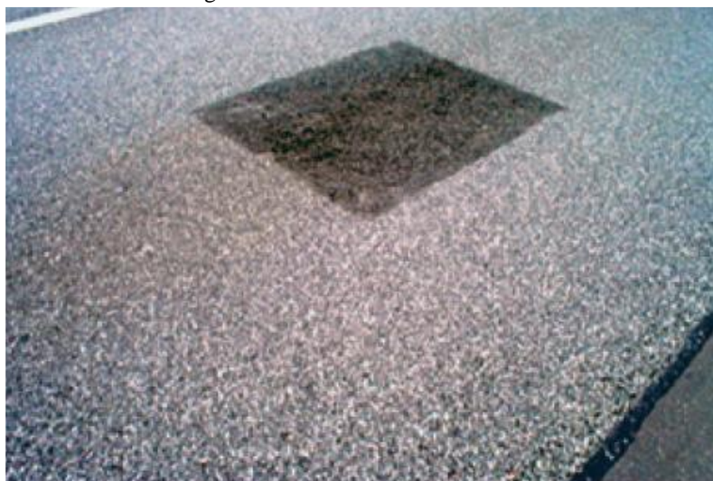
Figura 14 - Remendo bem executado.
