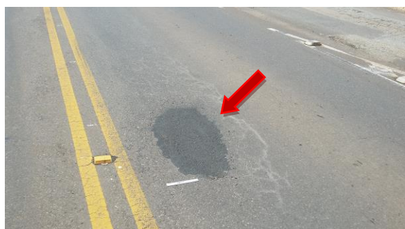
Remendo do Revestimento.
