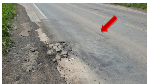
Remendo do Revestimento com deterioração
