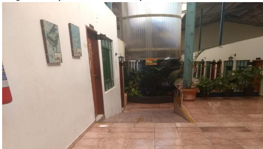
Figura 7 - Rampa e escada de acesso ao pavimento térreo 1
