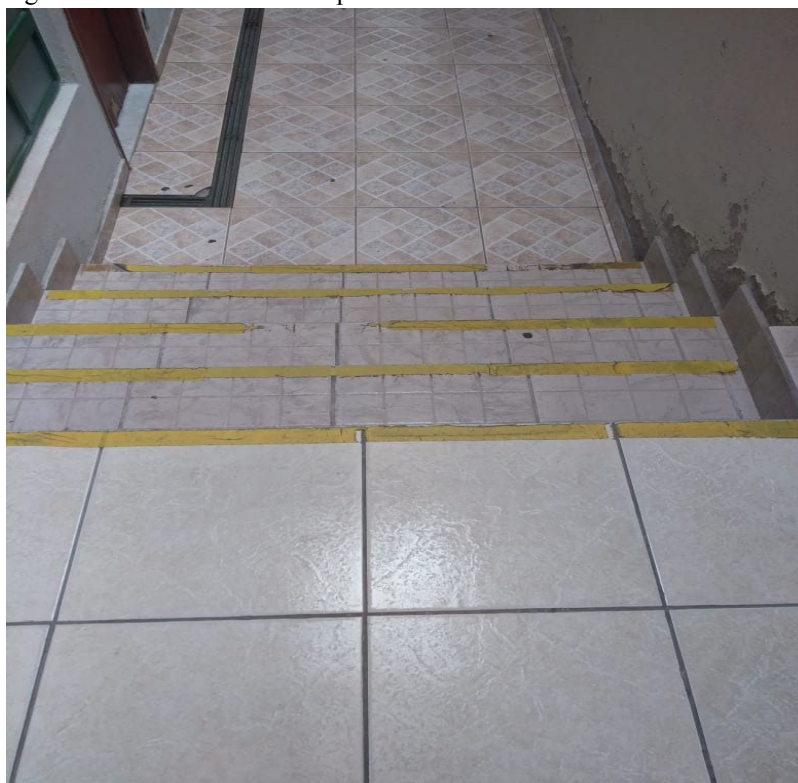
Figura 9 - Escada de acesso ao pavimento térreo 3
