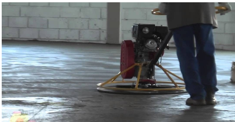
Fig. 03 - Acabadora mecânica de superfície
