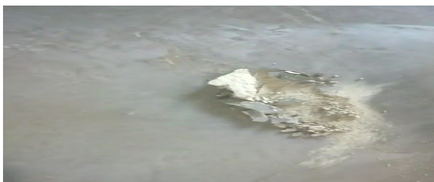
Fig.04 - Deslocamento no início de pega do concreto
