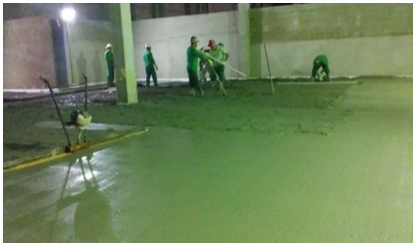
Fig.02 - Nivelamento de concreto com a utilização de régua vibratória
