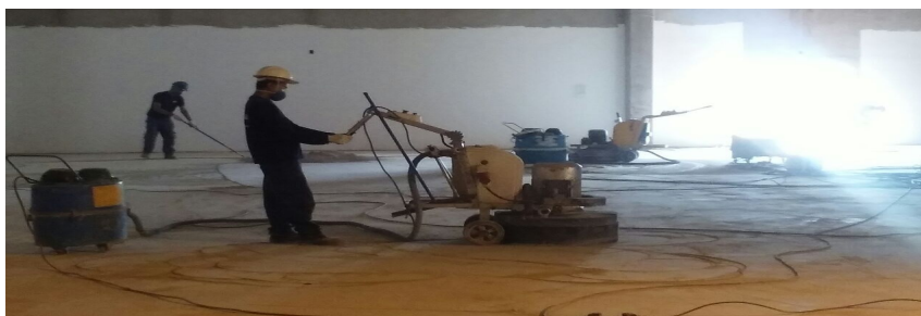
Fig.08 - Lixando o concreto
