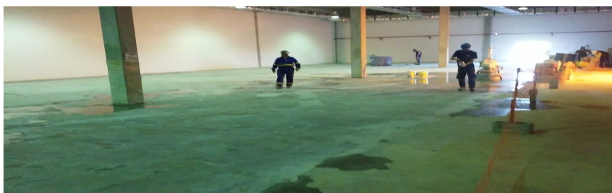
Fig.10 - Aplicação do produto com base epóxi no piso industrial
