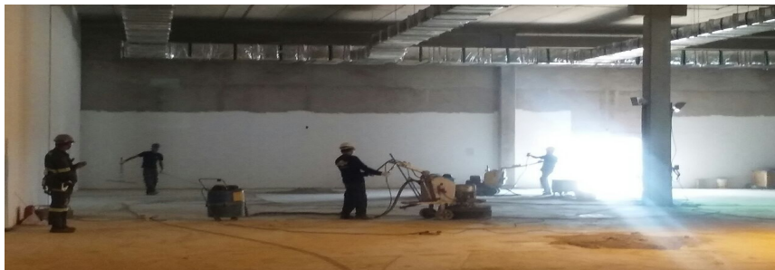
Fig.09 - Lixando e Apicoamento a área danificada
