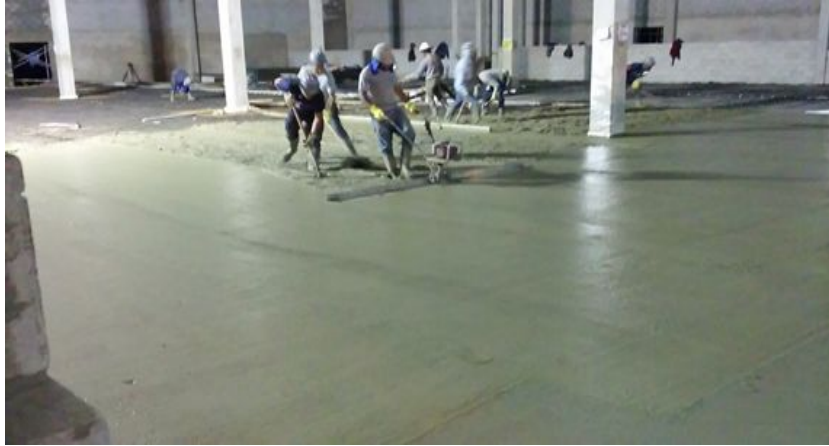
Fig.01 - Lançamento e espalhamento do concreto
