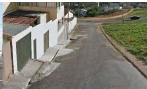
Figura 15 – Calçadas Fonte: acervo do autor.
