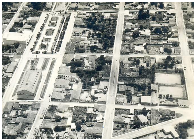
Figura 1. Imagem aérea do centro de Paraguaçu (MG) em 1946.
