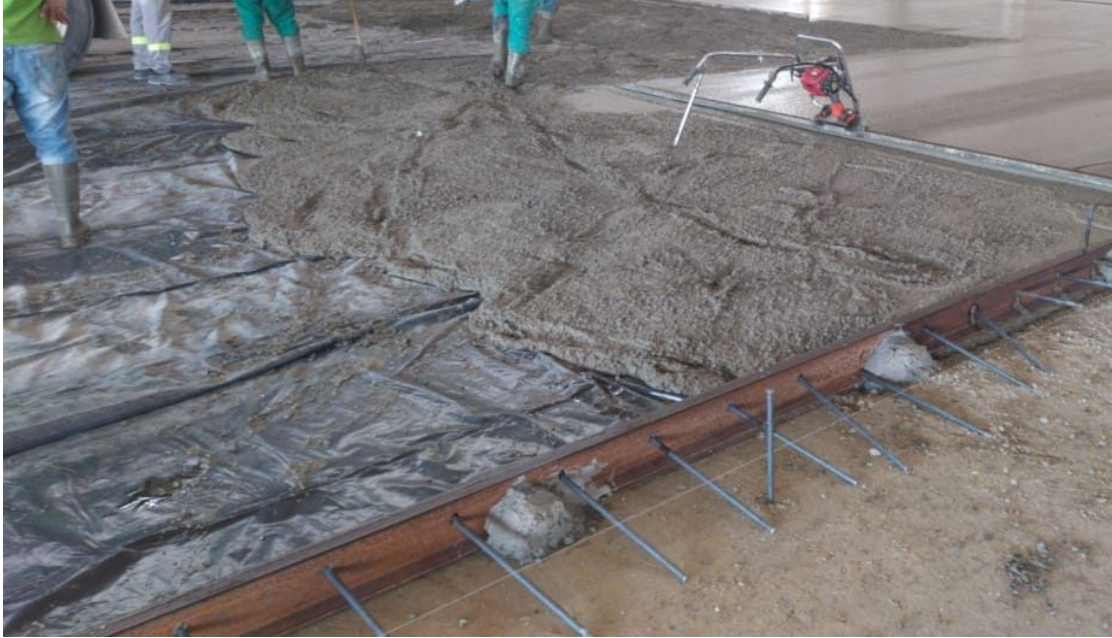
Figura 10 - Execução de camadas base - Obra Nova Minas.
