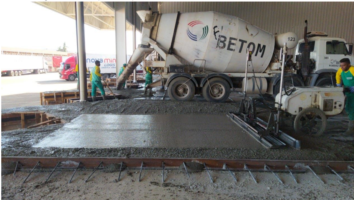
Figura 11 - Execução de lançamento e adensamento de concreto - Obra Nova Minas.
