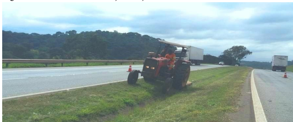
Figura 6 - Trator realizando serviço de roçada mecânica.
