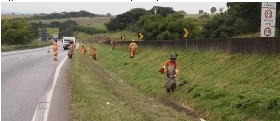
Figura 7 - Funcionários realizando serviço de roçada manual.
