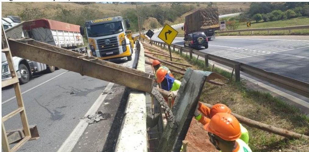
Figura 9 - Recuperação de barreira de concreto.
