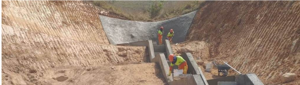
Figura 1 - Funcionário utilizando EPI (luva de látex) para rebocar uma drenagem.
