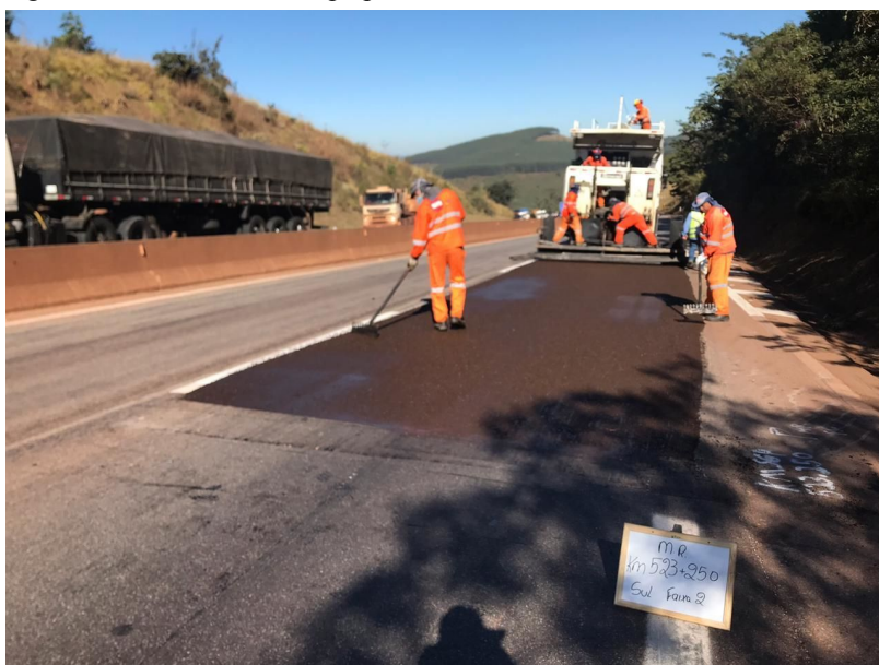
Figura 10 - Rastelando a Capa para Acabamento
