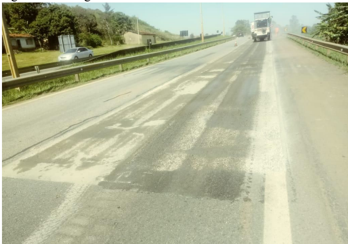
Figura 6 - Fresagem de asfalto a frio
