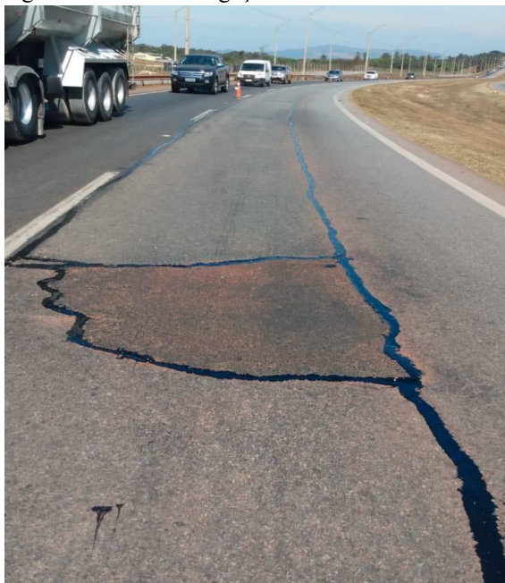
Figura 5 - Pintura de ligação
