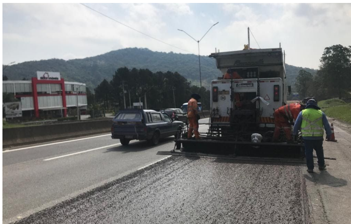
Figura 13 - Recomposição da Capa do Pavimento com o MRAF
