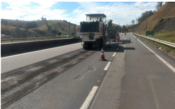
Figura 12 - Corte da camada superior do pavimento (Capa)
