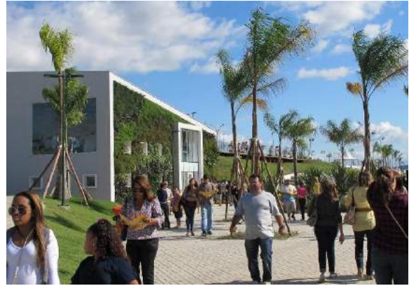
[74] Edificação com cobertura verde na parede.
