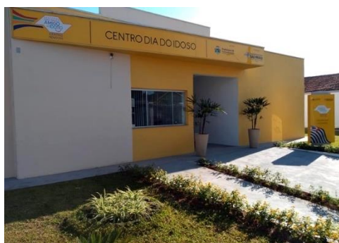
Fig. 9: Centro Dia do Idoso, em Pindamonhangaba (SP).
