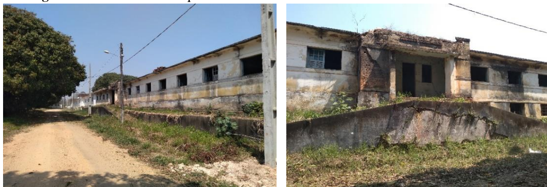
Fig. 3 e 4: Parte do edifício que se encontra desativado e em ruínas.
