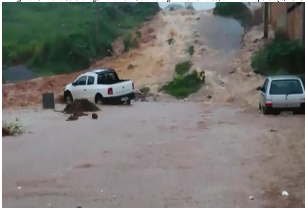
Figura 23: Falta de drenagem na Rua Gutemberg Moreira Leite, em Boa Esperança, 2020
