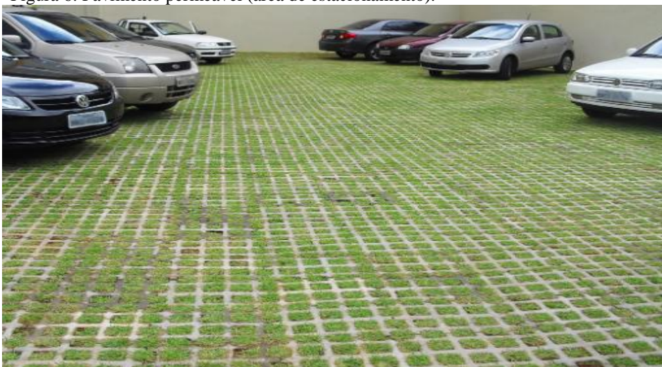
Figura 6: Pavimento permeável (área de estacionamento).
