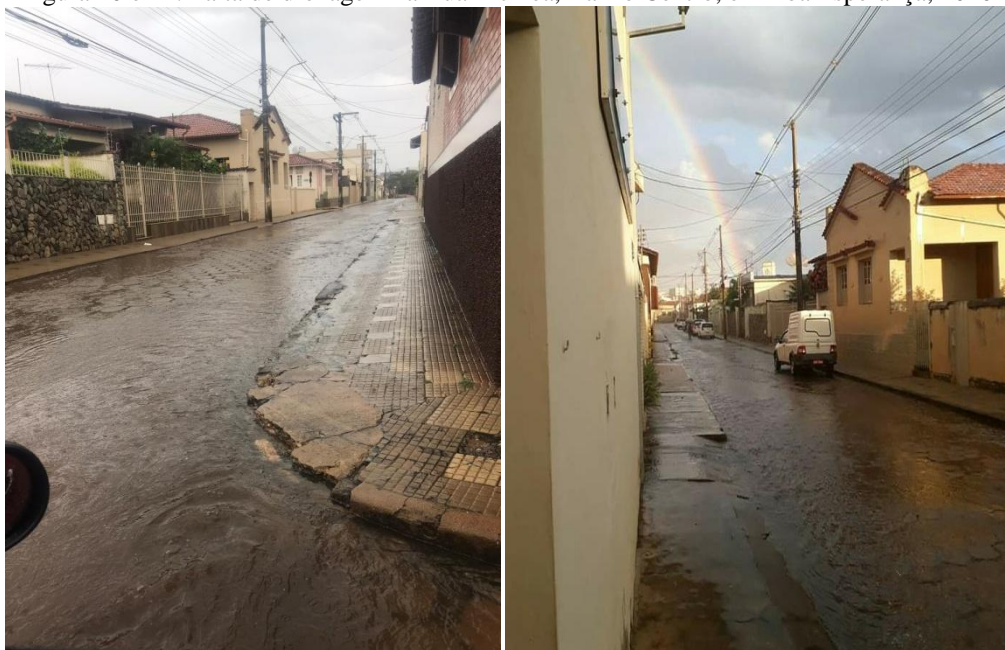
Figura 20 e 21: Falta de drenagem na Rua Ilicínea, Bairro Centro, em Boa Esperança, 2020
