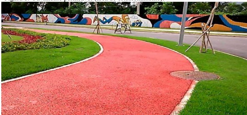
Figura 8: Pavimento permeável (área de estacionamento).
