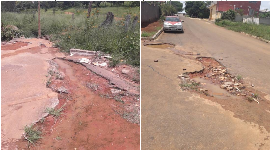
Figura 29 e 30: Aspectos das Estruturas existentes na pavimentação em Boa Esperança, 2020.
