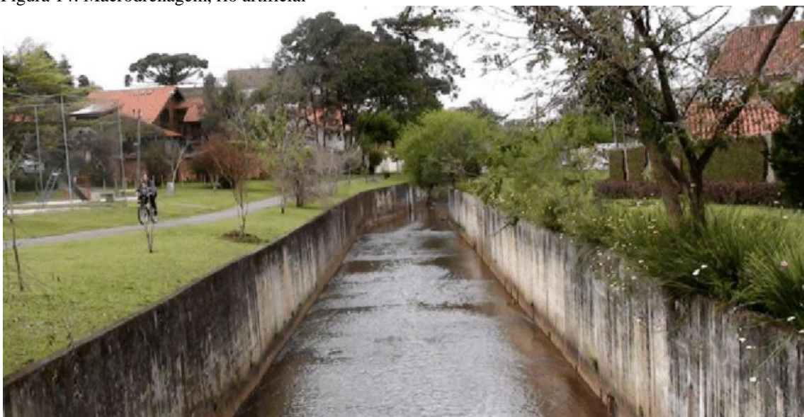
Figura 14: Macrodrenagem, rio artificial
