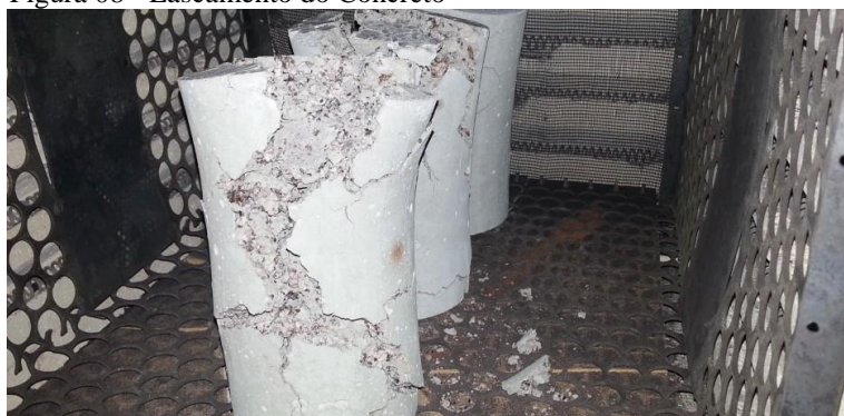
Figura 08 - Lascamento do Concreto
