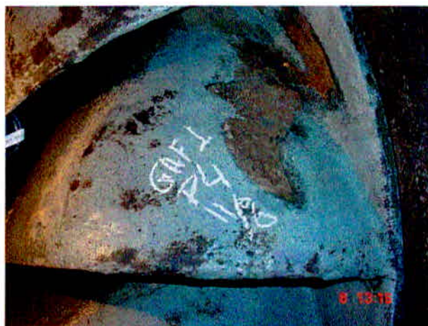
Figura 9. Pá nº4 da Turbina Francis (G1) – Usina de Gafanhoto – MG. Fonte: CEMIG - Gerência de Manutenção mecânica da Geração.
