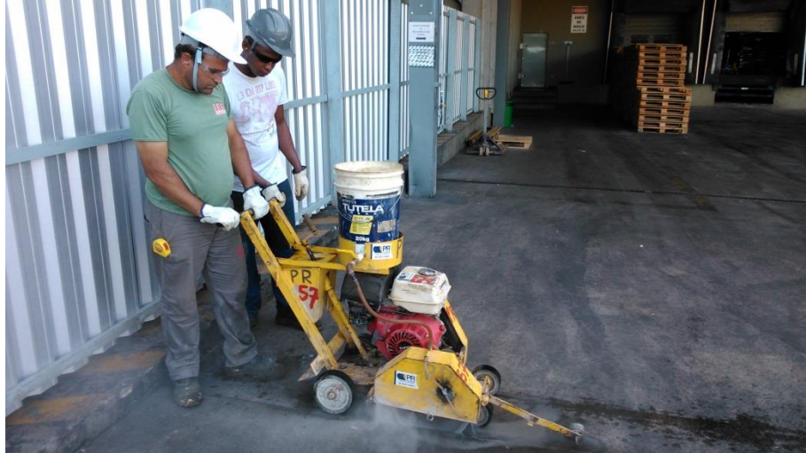
Figura 19 – Corte do piso com máquina clipper
