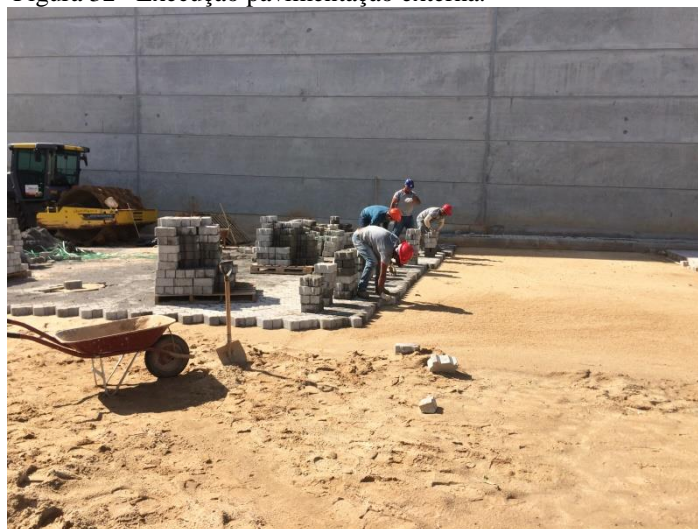
Figura 32– Execução pavimentação externa.
