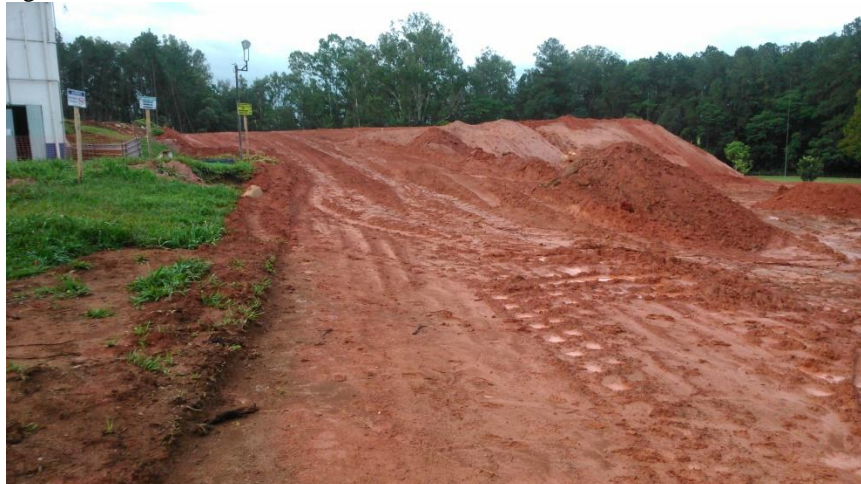
Figura 21 – Entrada da obra
