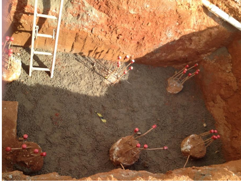
Figura 23 – Proteção dos vergalhões
