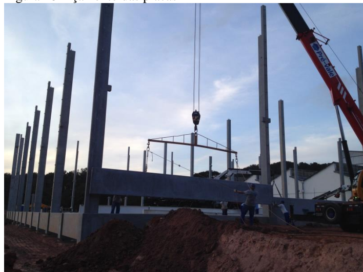
Figura 28– Içamento das placas
