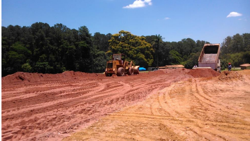
Figura 20 – Movimentação de terra
