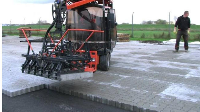
Figura 36 – Pavimentação Mecanizada
