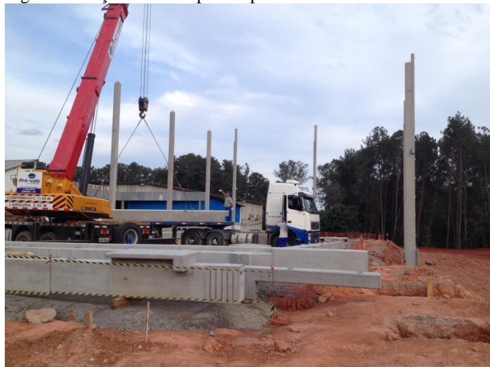
Figura 26 – Içamento dos pilares pré-moldados
