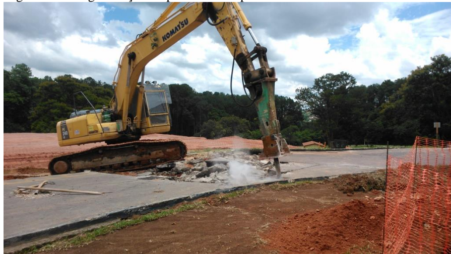
Figura 18 – Fragmentação do piso com rompedor hidráulico.
