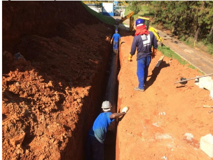
Figura 38– Locação da tubulação
