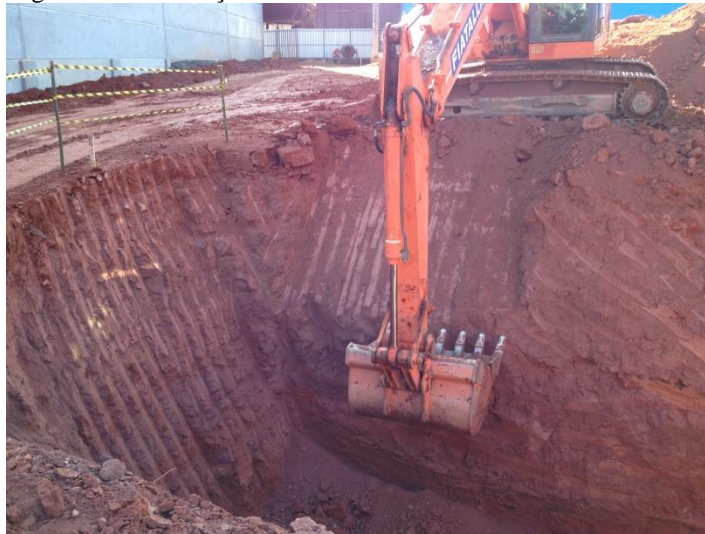
Figura 37 – Escavação de vala
