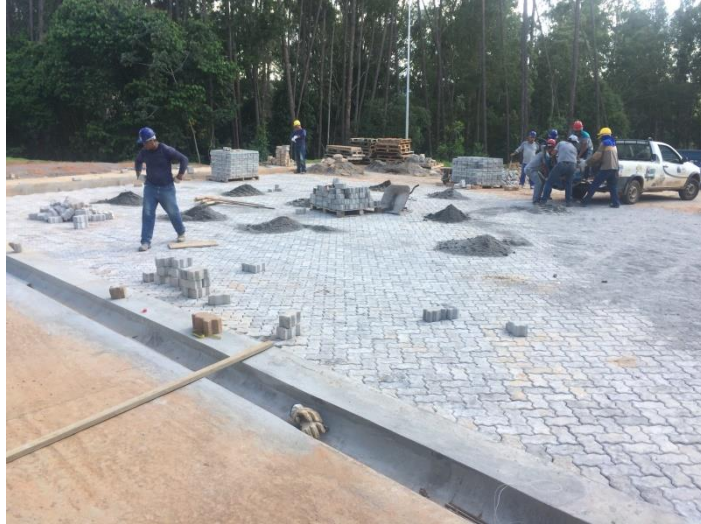
Figura 33 – Execução pavimento intertravado.
