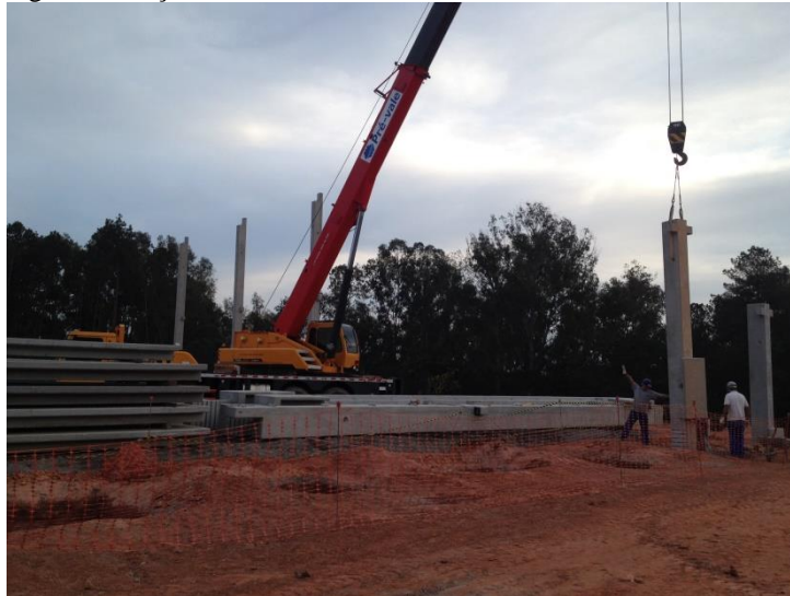
Figura 27 – Içamento Pilares
