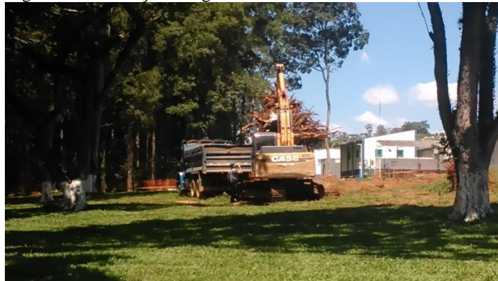
Figura 16 – Remoção dos galhos
