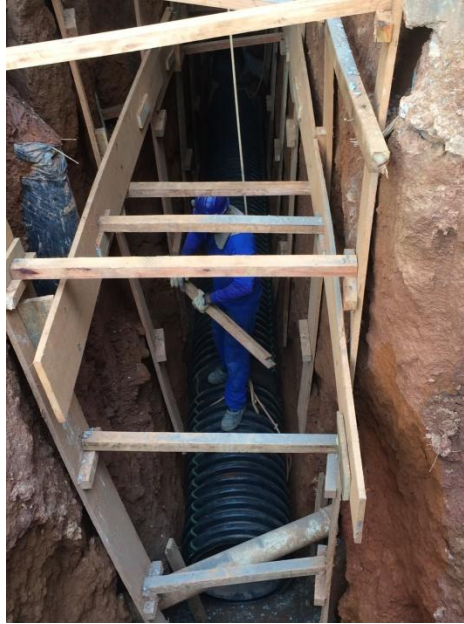
Figura 39– Escoramento do barranco
