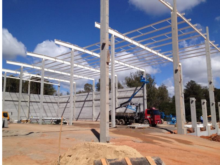
Figura 31 – Montagem cobertura metálica
