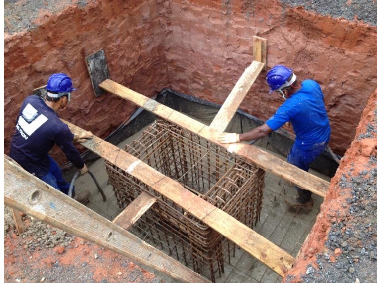
Figura 25 – Montagem dos blocos
