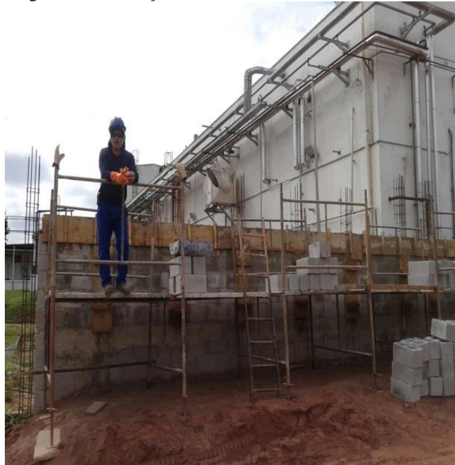
Figura 29 – Execução Alvenaria
