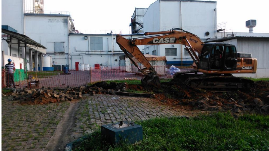
Figura 17 – Retirada do piso com retroescavadeira
