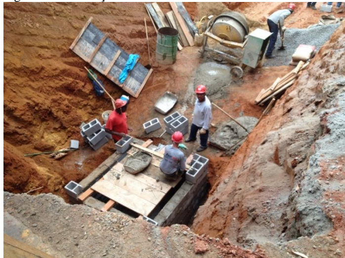
Figura 40 – Execução de caixa no fundo da vala
