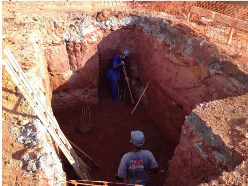
Figura 24 – Escavação blocos de fundação
