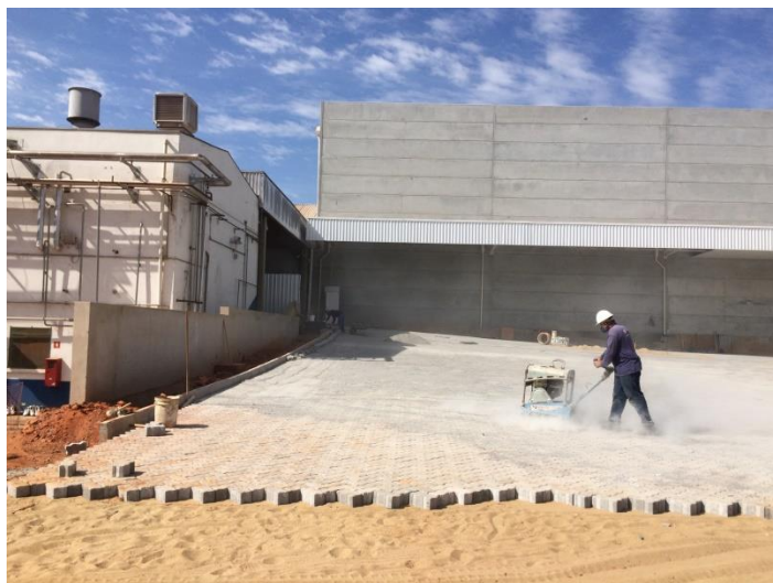
Figura 34 – Acabamento com placa vibratória
