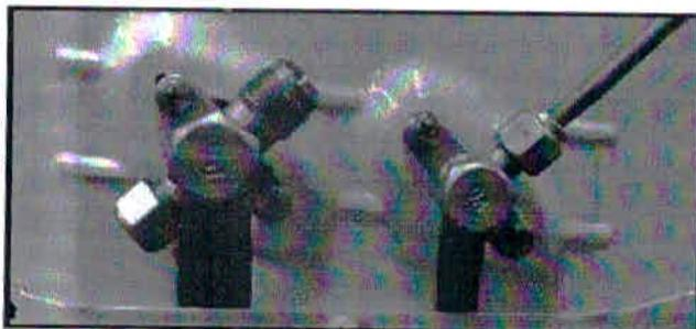
FIGURA 30 - CONEXÃO DA LINHA DE EXPANSÃO DA UNIDADE CONDENSADORA
