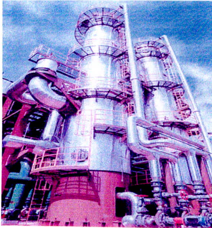
Figura 06- Evaporadores de filme descendente
