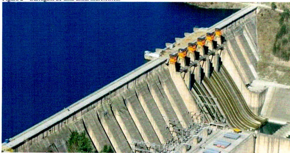
Figura 2 – Barragem de uma usina hidrelétrica.
