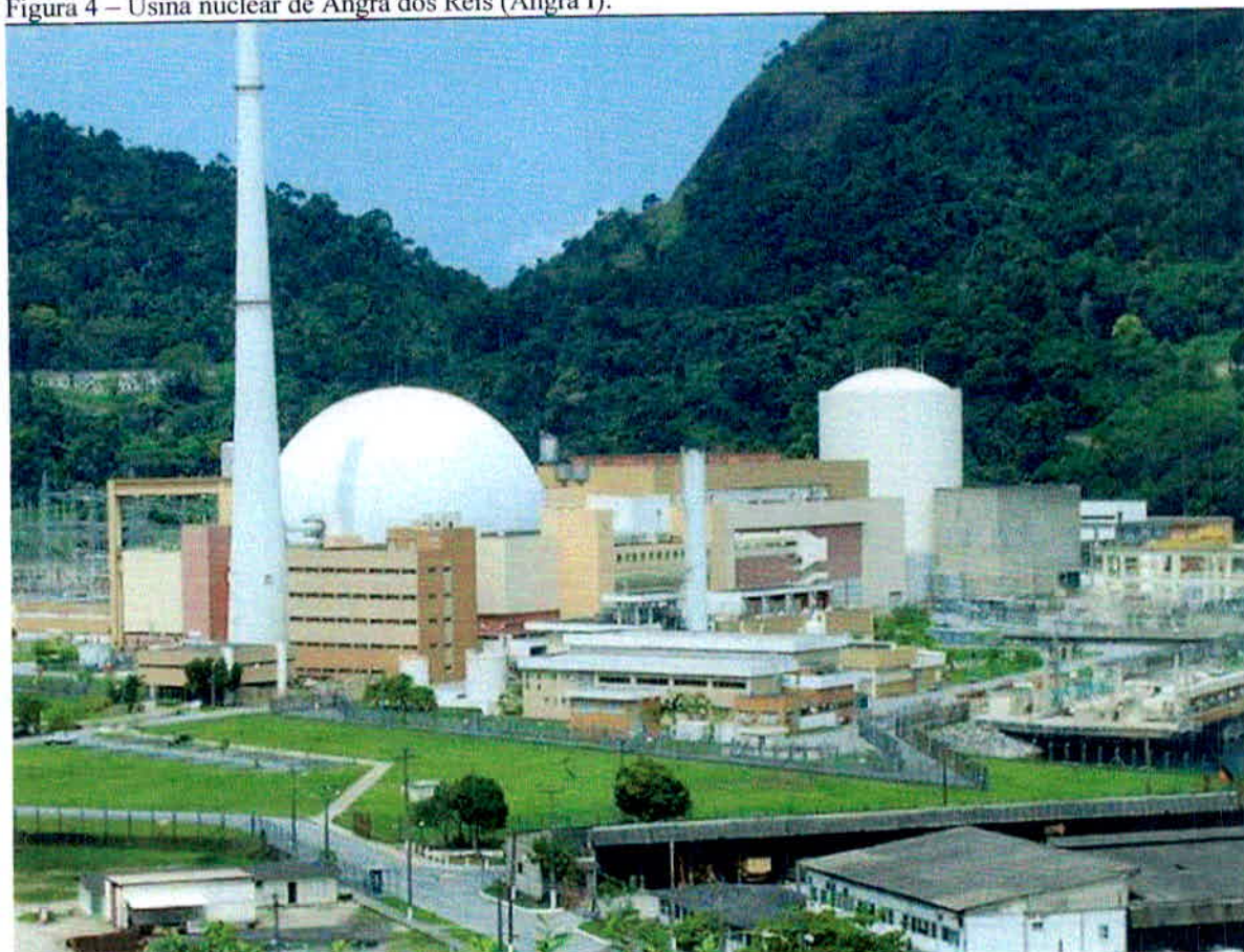
Figura 4 – Usina nuclear de Angra dos Reis (Angra I).
