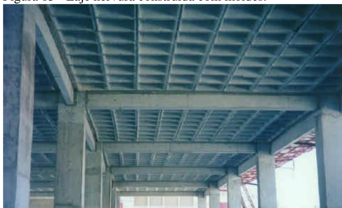
Figura 05 - Laje nervura construída com moldes.
