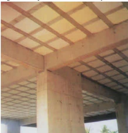
Figura 06 - Laje nervurada com utilização de EPS.
