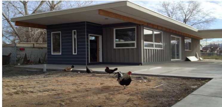
Fonte: (Minha Casa Container, 2014).
