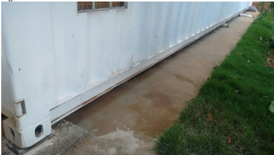
Figura 13: Base da casa container.
