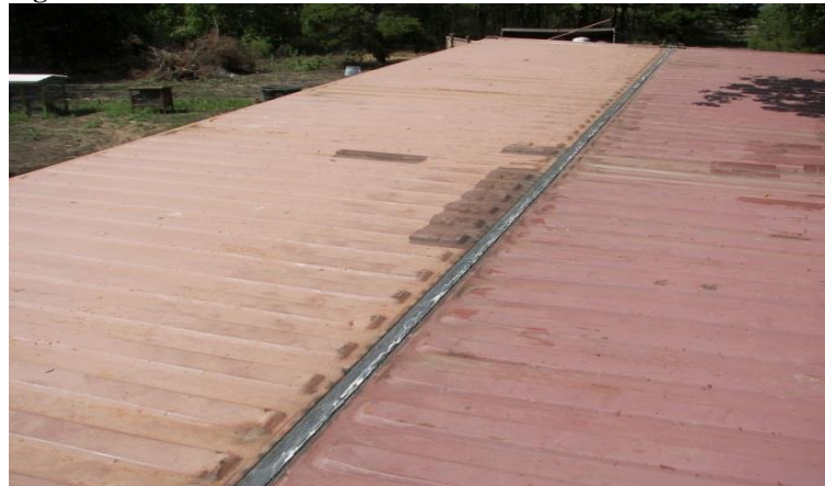
Figura 14: Solda entre os containers.
