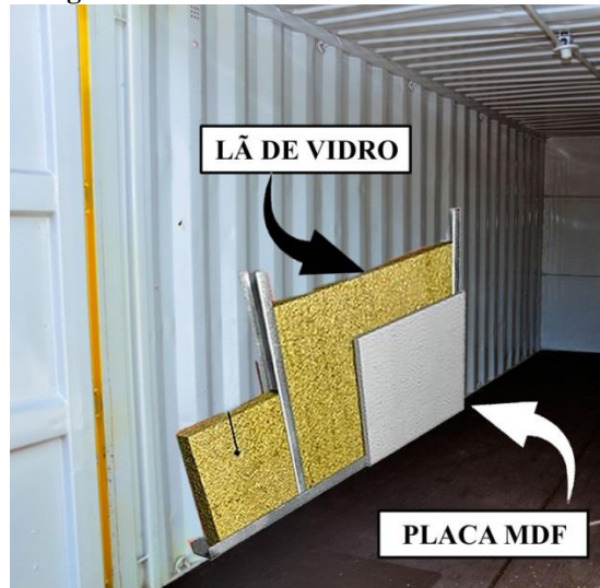
Figura 16: Camadas de revestimento do container.
