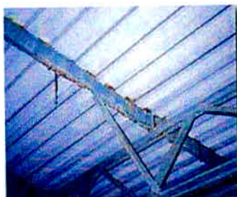
Figura 4: Corrosão Galvânica
