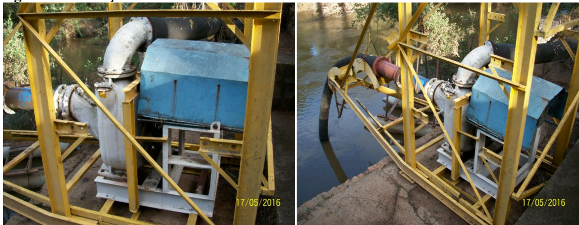
Figura 14 - Estação elevatória
