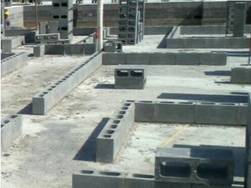
Figura 8 – Foto com o início do assentamento da alvenaria do pavimento inferior.
