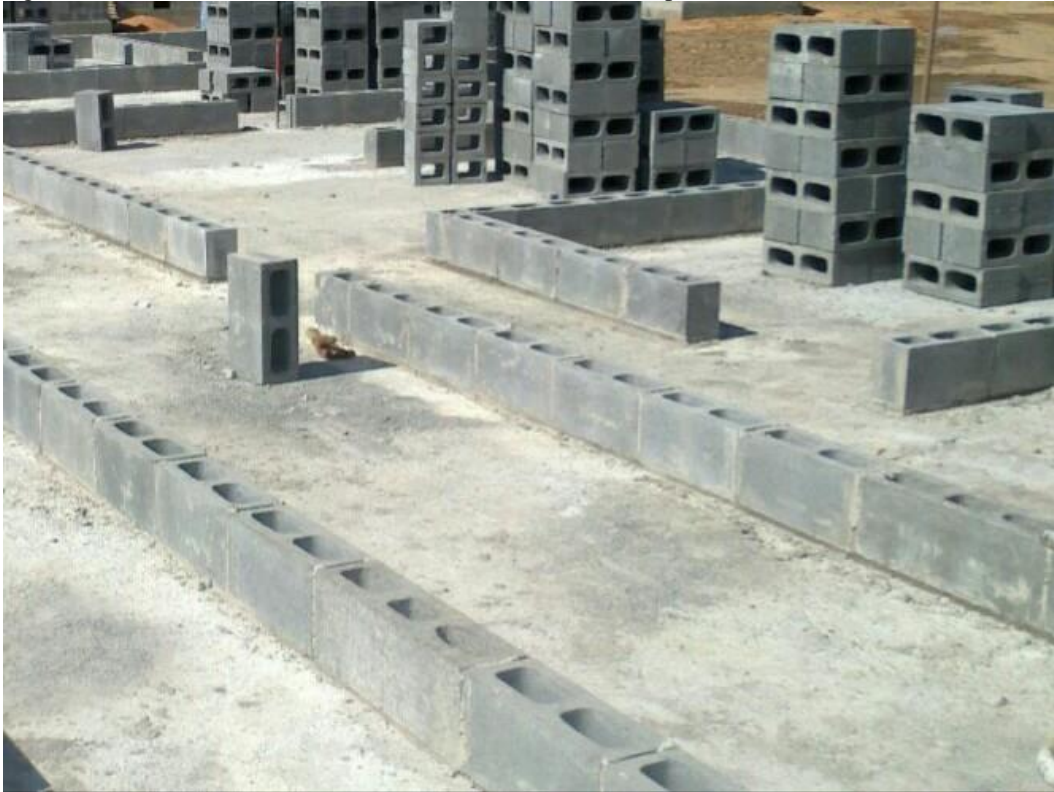
Figura 9 – Foto com o início do assentamento da alvenaria do pavimento inferior.
