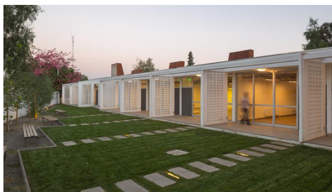
Figura 21: Salas do Centro Cultural de Lampa
