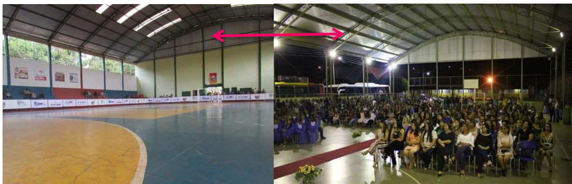
Figura 11: Cobertura do Ginásio e da Escola Municipal
