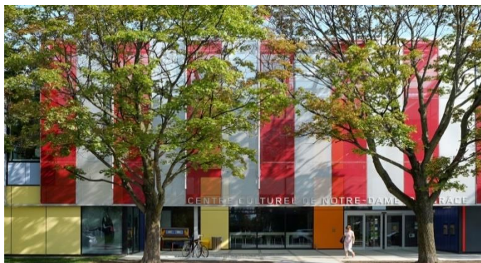
Figura 18: Fachada do Centro Cultural de Notre-Dame-de-Grâce
