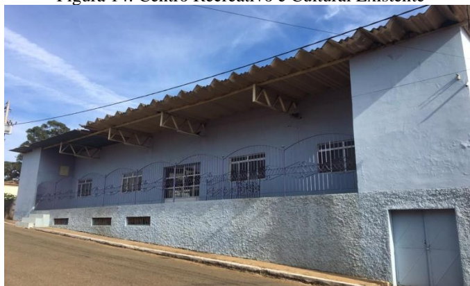
Figura 14: Centro Recreativo e Cultural Existente
