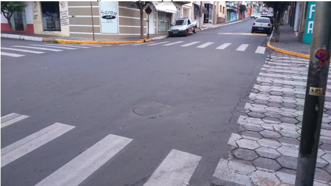
Figura 26 – Alturas variáveis das guias das sarjetas e poço de visita coberto com revestimento asfáltico.
