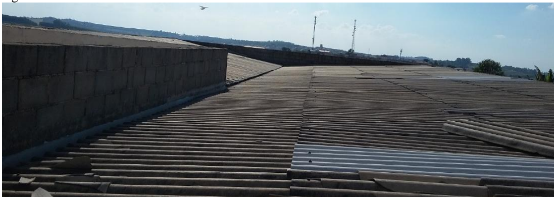
Figura 3 - Cobertura em telha de fibrocimento.
