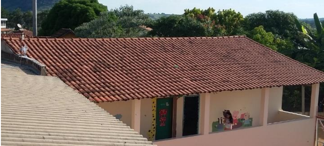
Figura 2 - Cobertura em telha cerâmica.
