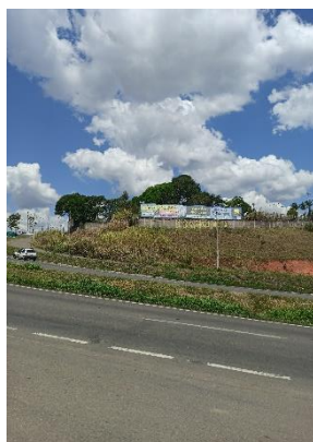
Figura 23: Vista posterior 1, ao lado da Av.dos Viajantes. Fonte: acervo do autor.
