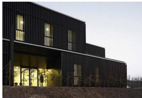
Figura 7: Vista fachada do projeto Shelter Home. Fonte: Shelter Home (2010)
