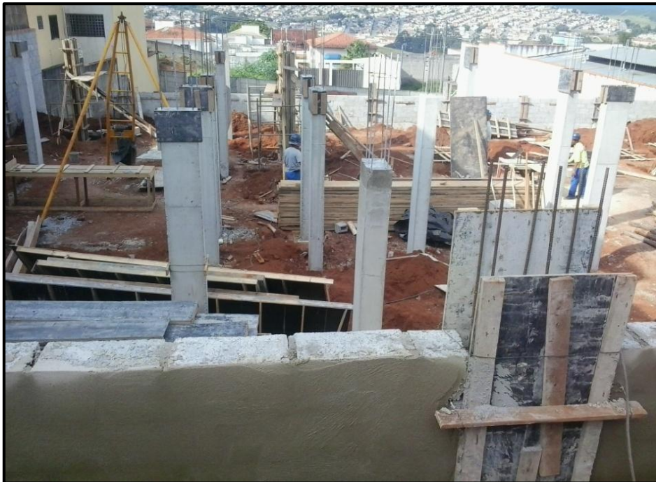
Figura 12 - Primeiros pilares concretados.
