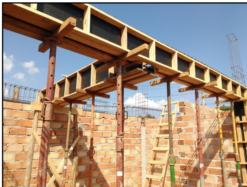
Figura 4 - Fôrmas de madeira.
