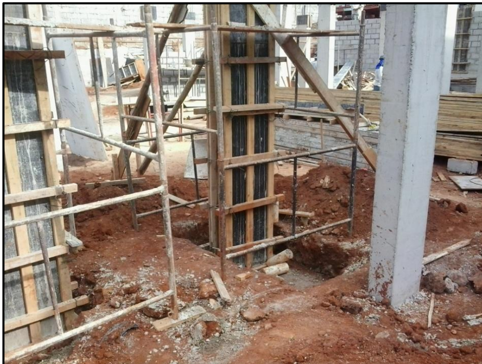
Figura 14 - Pilares ainda com fôrma.
