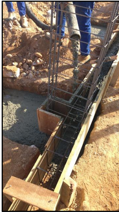
Figura 5 – Concretagem de viga baldrame.
