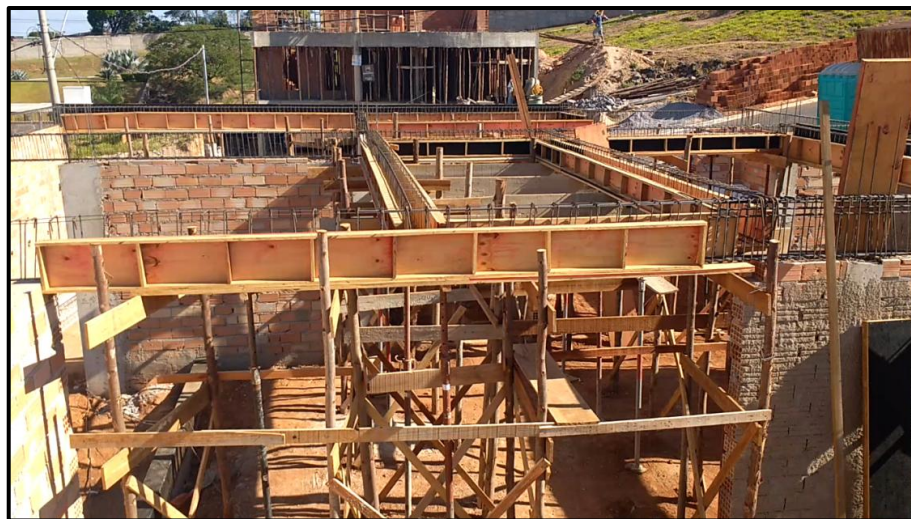
Figura 7 – Fôrmas com escoramento.
