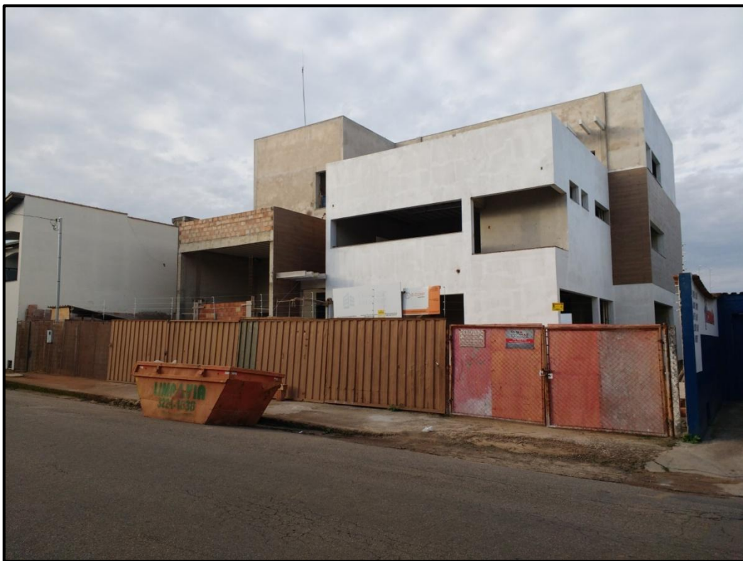
Figura 15 - Fachada da obra.
